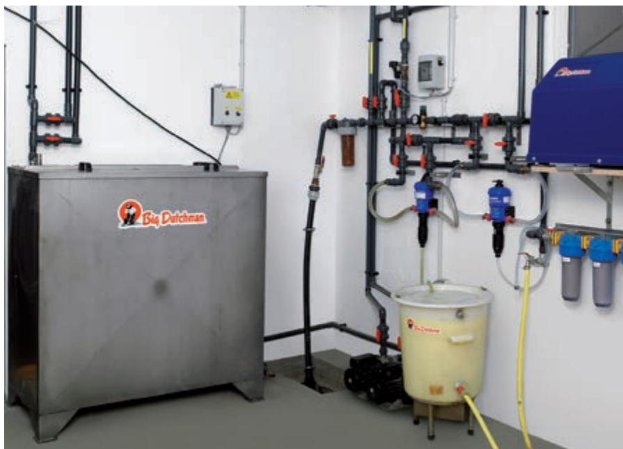
Stanza di servizio con una vasca piccola (60 l) e una grande (1000 l) in acciaio inox per il mixaggio dei medicinali
